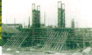
岩淵水門の工事現場
